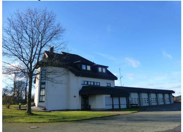
Feuerwehrgerätehaus in Kirchen, Katzenbacher Straße
