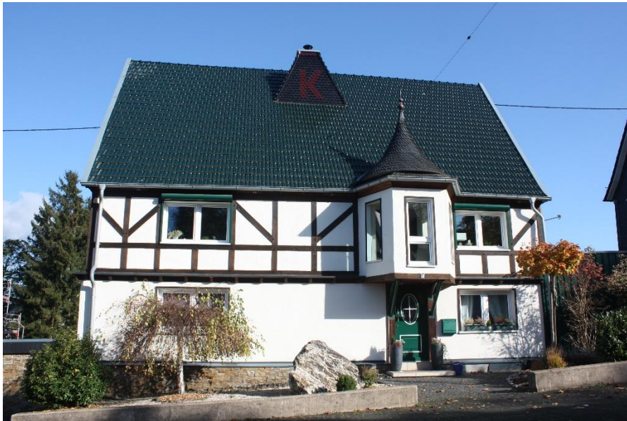
Abb. Gebäude in der Hauptstraße in gutem Zustand (Quelle: eigene Aufnahme, Kirchen (Sieg) 10/2024)
