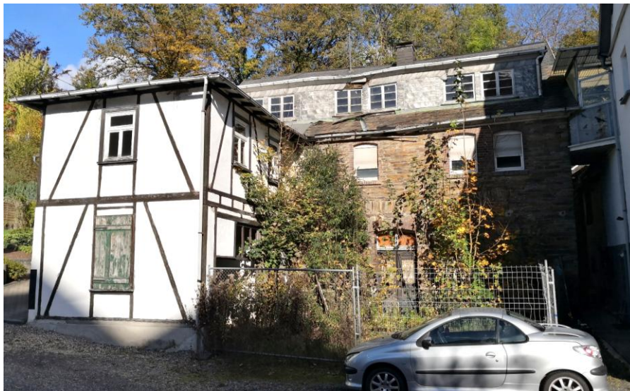
Abb. Ehemalige Zuckerwarenfabrik in der Klotzbachstraße, einzustufen als Schrottimobilie (Quelle: eigene Aufnahme, Kirchen (Sieg) 10/2024)
