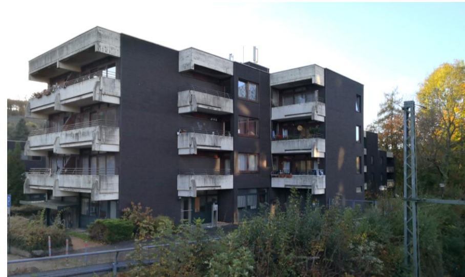
Abb. Gebäude Brückenstraße 1-5 (Quelle: eigene Aufnahme, Kirchen (Sieg) 10/2024)
