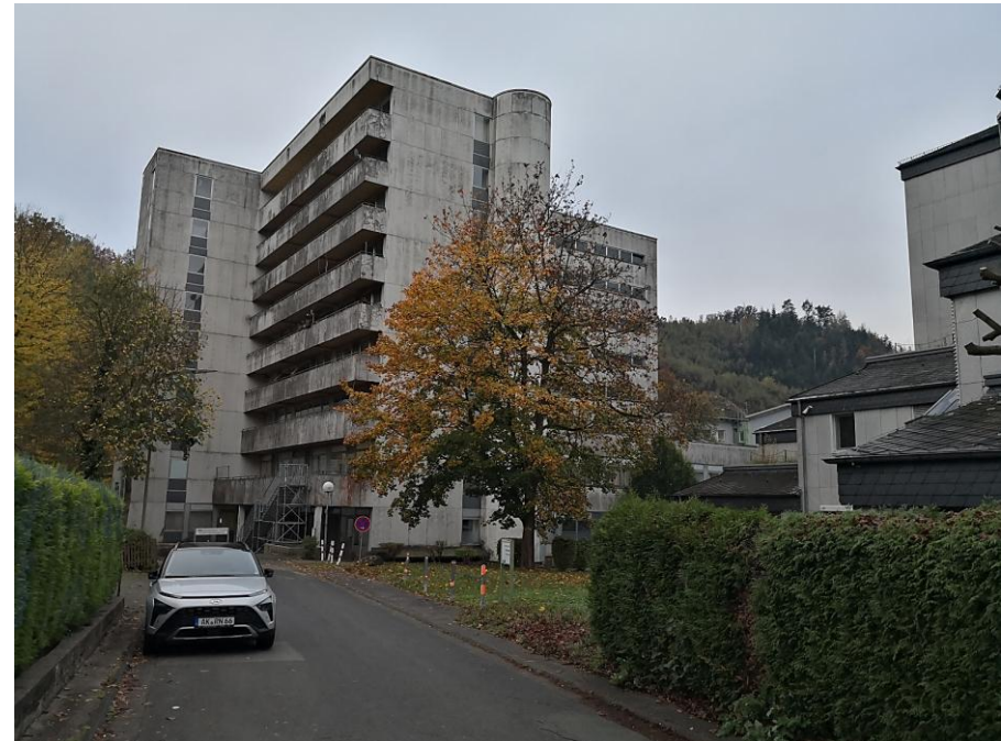
Abb. Gebäude Sandstraße 8 (Quelle: eigene Aufnahme, Kirchen (Sieg) 10/2024)
