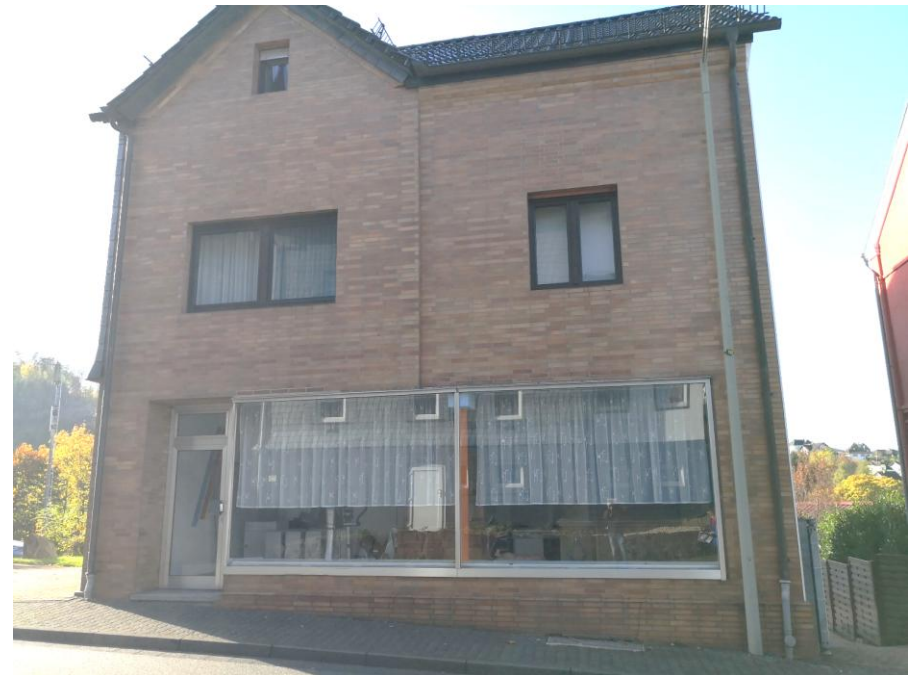
Abb. gestalterisch v.a. im Erdgeschoss stark überformtes Gebäude in der Kirchstraße (Quelle: eigene Aufnahme, Kirchen (Sieg) 10/2024)
